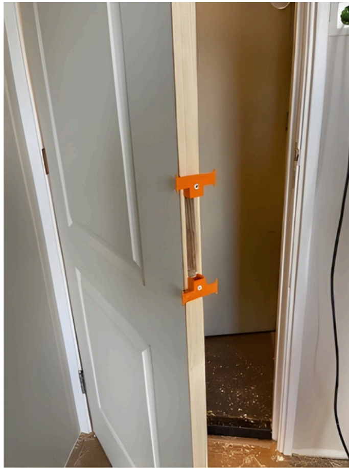
2. Plaatsing steunblokjes
